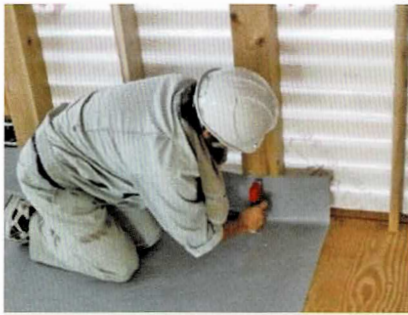
①床の下地に敷きつめて留めます(タッカー留め)
