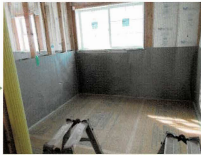
②同じく壁の下地にも敷きつめます
