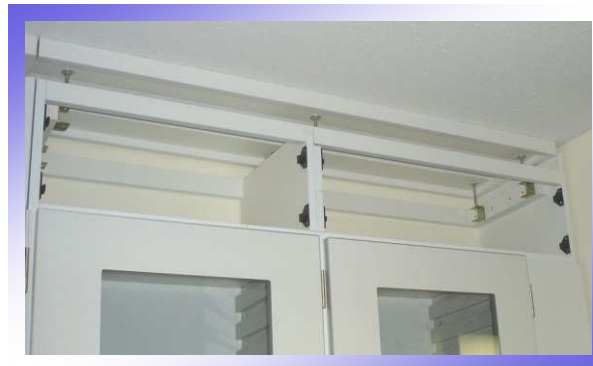
フロントパネルを外したところ 上部のアジャスターで高さ調整をする。
